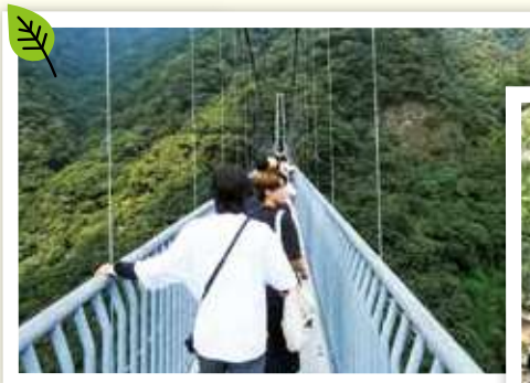
多くの学生が野外実習で訪れる 照葉大吊橋
