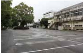
町公民館周辺駐車場舗装補修整備
