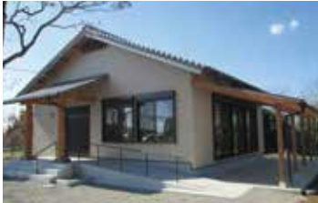
陣之尾公民館建設
