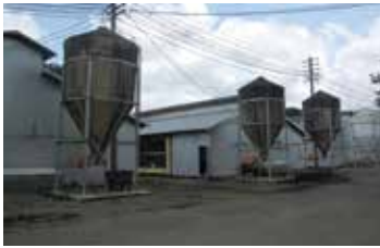
JA養豚センター建設
