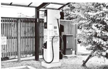
■ほんものセンター横に設置中のEVスタンド
