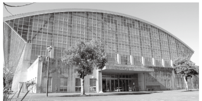
避難所に適さない総ガラス張りドーム
