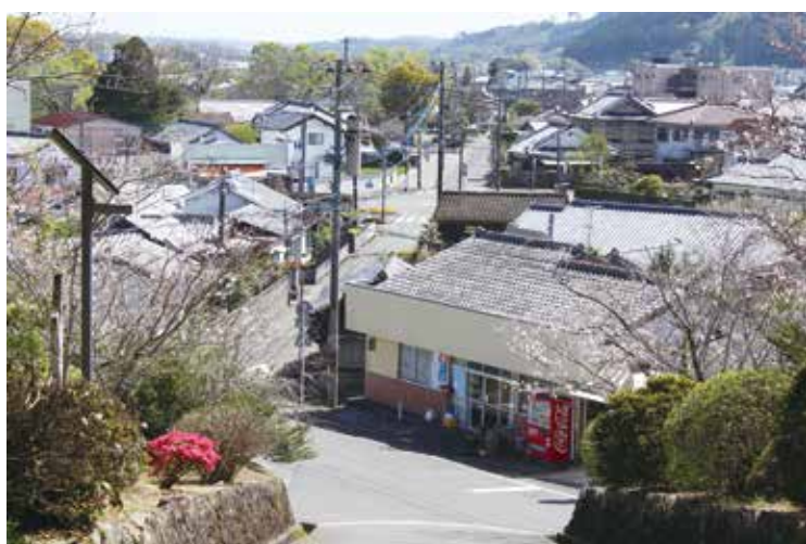
無電柱化整備予定の横町栄町線
