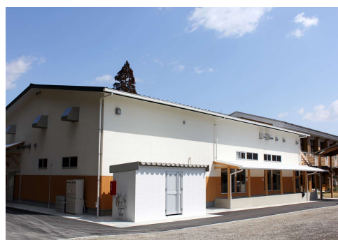
綾小学校給食室
