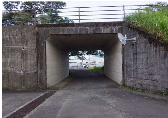
図 10 道路を跨ぐ橋梁の例（綾町管理 第1堤原橋）
