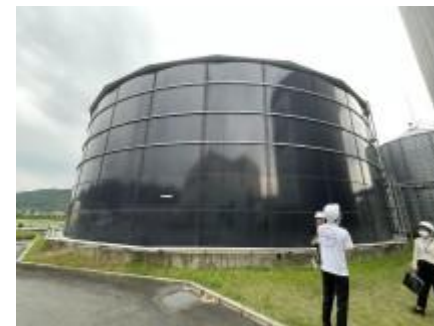
福岡県大木町のバイオガスプラント
